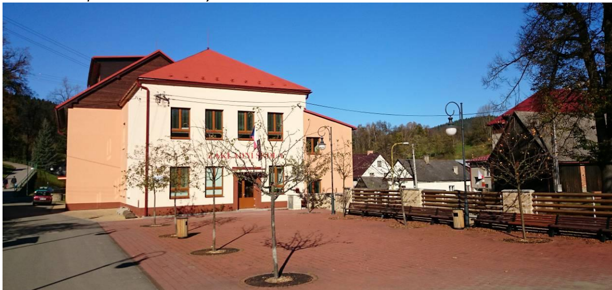
Obr. 4. Zateplená budova školy a rekonstruovaná náves
