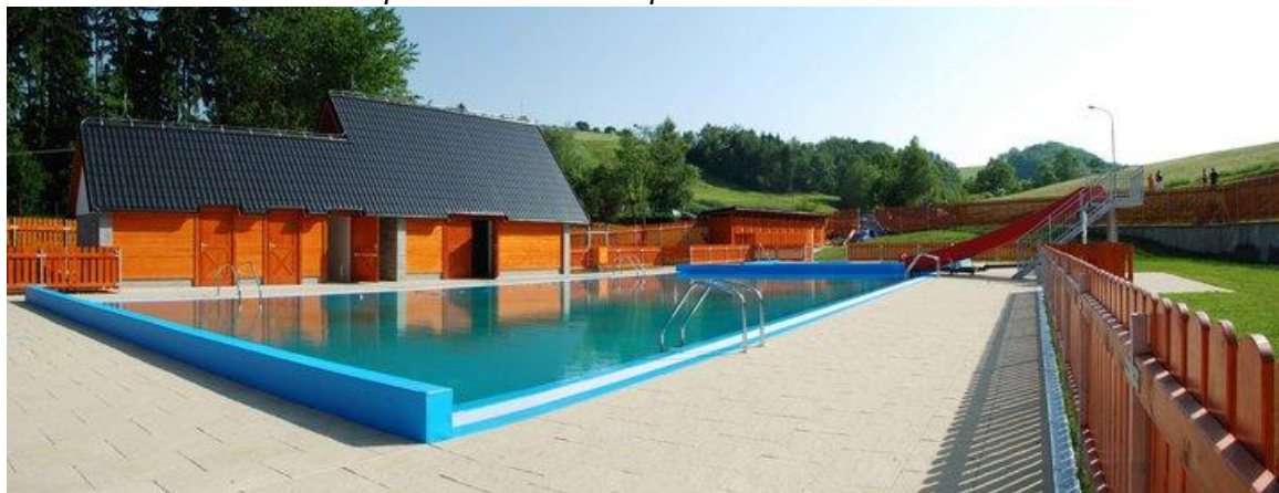
Obr. 5. Rekonstruované koupaliště v místním sportovním areálu
